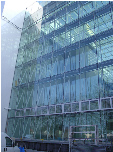
Gebäude mit Doppelfassade und Atrium (Bild des Verfassers)
